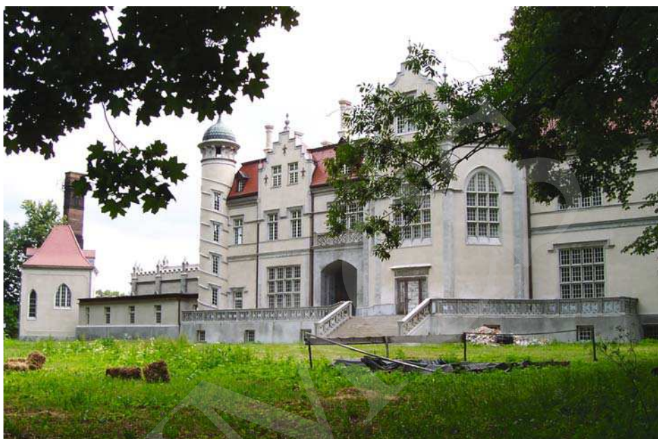
Il. 5. Pałac w Jabłoni, elewacja ogrodowa. Fot. A. Cebulak, lipiec 2006.
