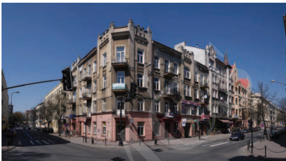
Ilustracja 11. Kamienica przy ul. Chopina 15. Fot. P. Maciuk 2010.
