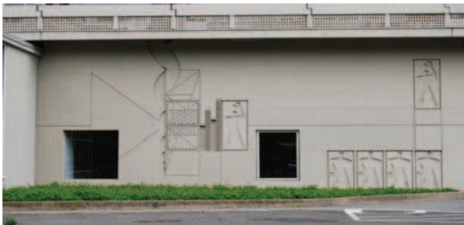
Ilustracja 12. Modulator na elewacji Jednostki Berlińskiej, fot. A. Pilip (2010).
